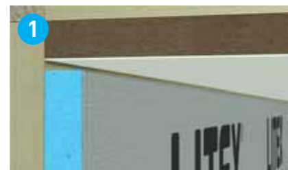
Avstand til tak og tilstøtende vegg: 2-5 mm klaring mot tak og tilstøtende vegg. Platen må ikke monteres i spenn.
