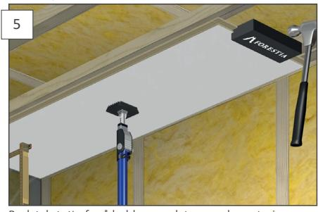
Bruk takstøtte for å holde opp platene ved monteringen. Forestia slagkloss må benyttes for å ikke ødelegge profilen når plata skal slås på plass. Denne slagklossen er tilpasset platens profil. Vis varsomhet når Forestia slagkloss benyttes.
