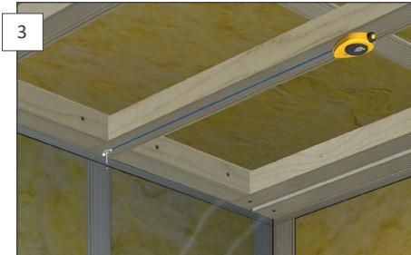
Montér første platerad etter snor. Husk at det skal være 10mm klarhet mot alle faste konstruksjoner. Megt viktig at underlaget er helt rett. Eventuelle ujevnheter i bindingsverket MÅ rettes opp før montering.
