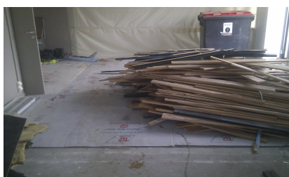
Beskyttelse av gulv under rehabilitering
