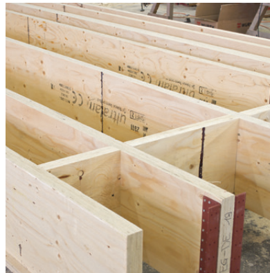
Eksempel på bjelkelagskonstruksjoner med Hunton Finerbjelken.
