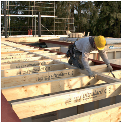
Eksempel på bjelkelagskonstruksjoner med Hunton Finerbjelken.
