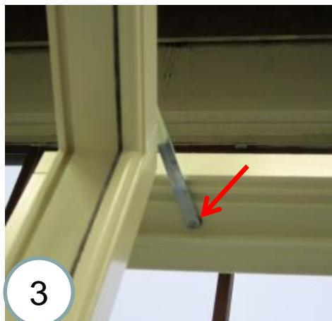
1. Monter plugg for vindbrems, med en skrutrekker, i topp av karm, i hull nærmest hengsleside som vist på bilde
