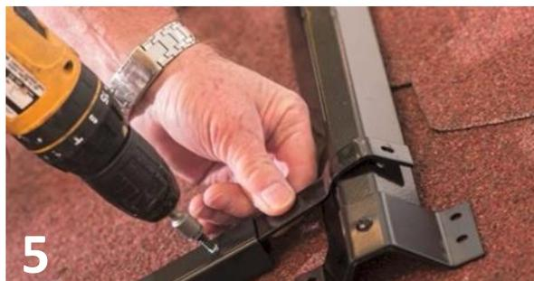
Fest øvre innfestestag til den øverste stigemodulen med skruer 6,3x25mm, og tilpass innfesteskinnen til stige og stag .
