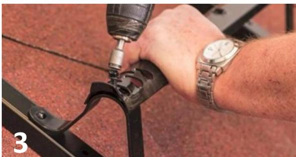
**3** Monter tverrtrinnene over de påmonterte skruene i stigevangene (NB! Materialforskyvningen skal synes i det store hullet) og skru godt fast.
