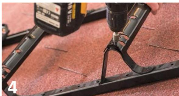
**4** Modulene skjøtes sammen som den første, demonter skruen, skyv lasken inn i stige-vangen, skru igjen og monter tverrtrinn. Stopp før siste modul.
