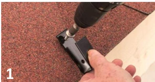
**1** Monter innfestingsbrakettene slik at de kommer mellom to taksperre. Husk å sette på pakning mellom brakett og tak. Fest brakettene med skruer 6,5x38mm.
