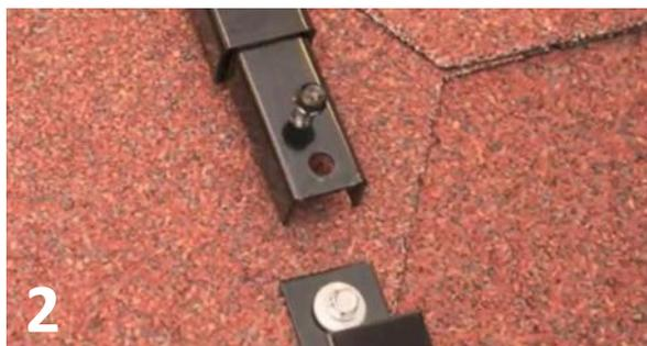
**2** Monter første stigemodul i de nedre festebrakettene ved å demontere skruen på skjøtelasken, skyve lasken inn i braketten og montere skruen igjen.
