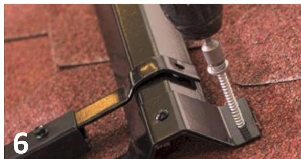
Skrue fast skinnen i taket med skruer 6,3x38mm. Skruene skal treffe mest mulig midt på tak-sperrene. Husk pakning mellom skinnen og taket
